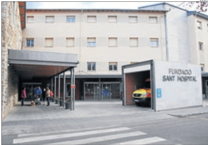
Les instal·lacions del Sant Hospital de la Seu d'Urgell.
