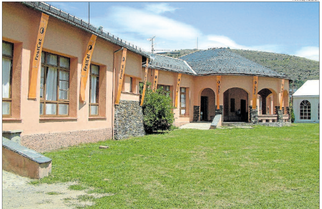
L'edifici actual de l'escola Jaume I de Llivia, que s'ampliarà amb una nova construcció d'aules i serveis
