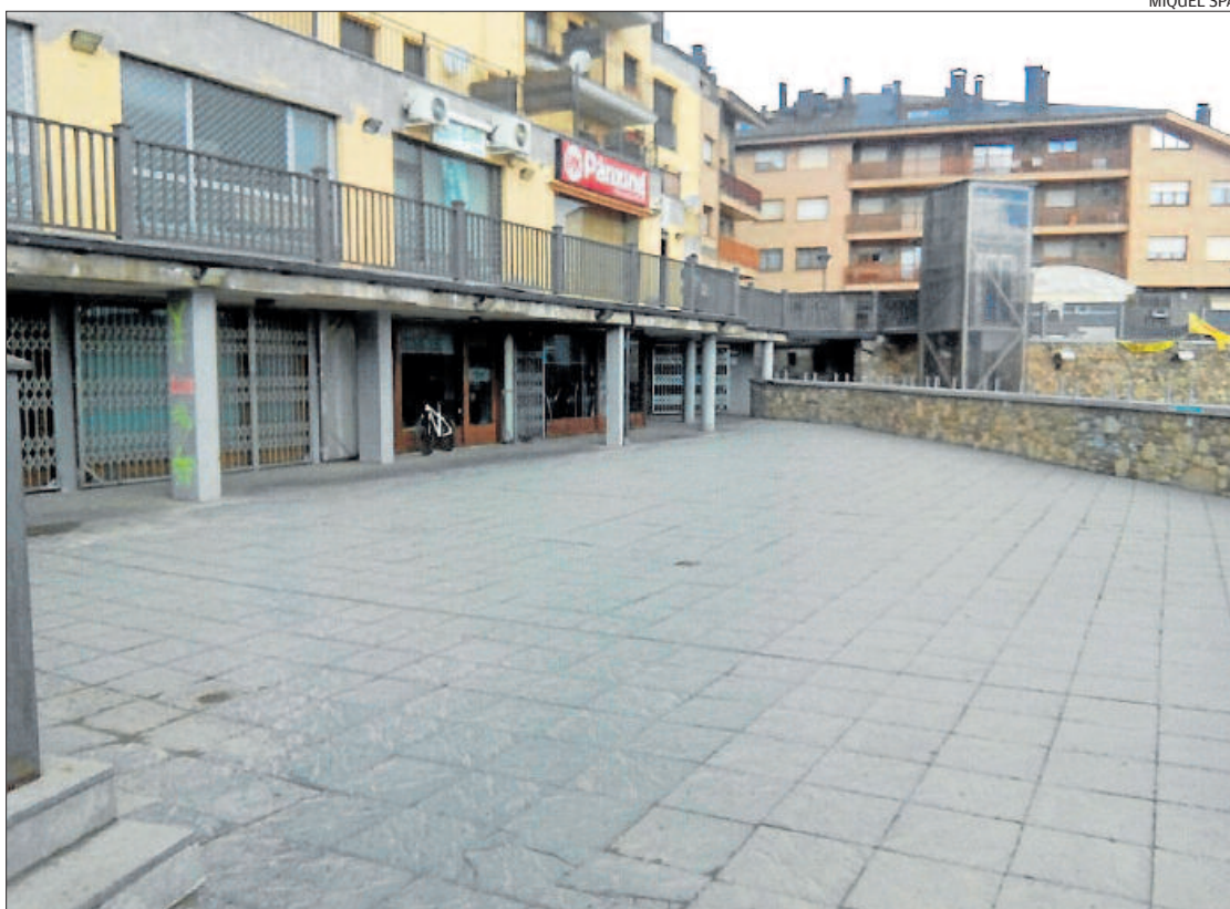
L'espai és en una zona de pas i alguns dels locals comercials que hi ha estan tancats
