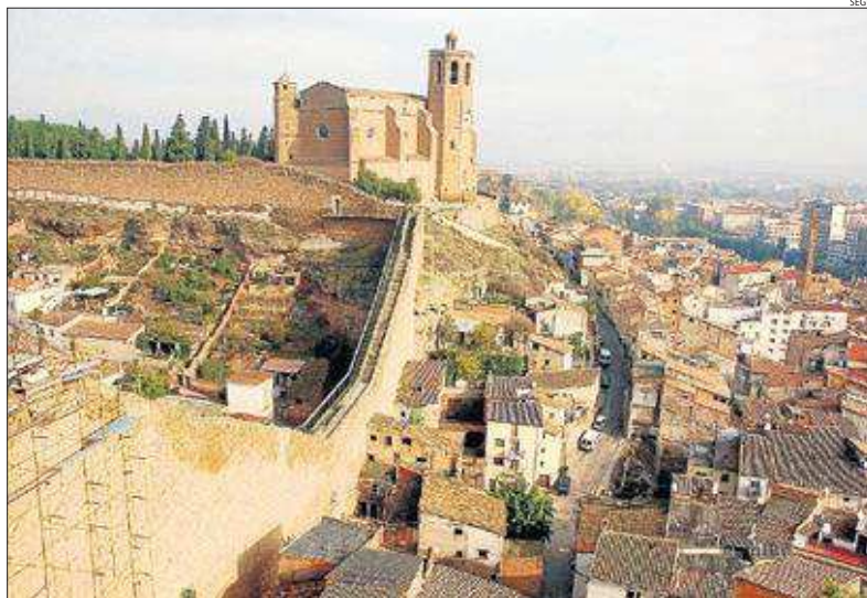
S'executarà la segona fase de millora de l'entorn de l'església de Santa Maria.
