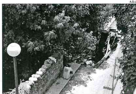
Les obres volen reforçar el paviment i els murs que delimiten aquest camí.
