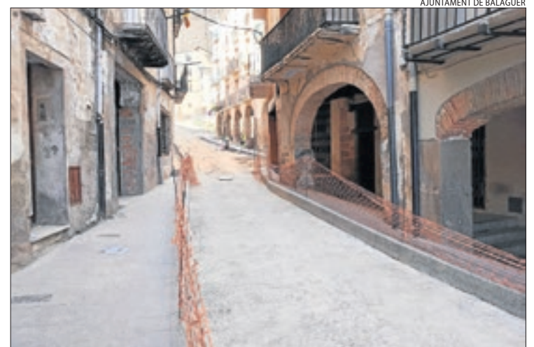
El carrer Botera de Balaguer, en obres.
