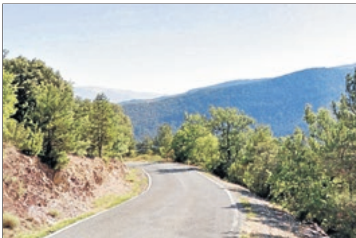
Un dels revolts tancats de la carretera C-462.
