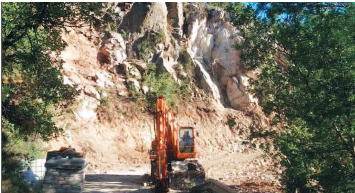
► Una màquina treballa a la carretera, fa uns dies.
