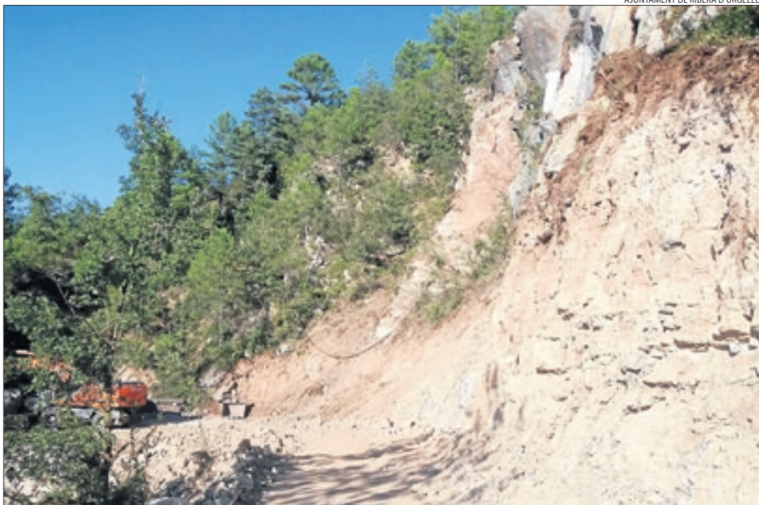
Les obres a la carretera de Torà de Tost van permetre ahir donar pas als primers vehicles.
