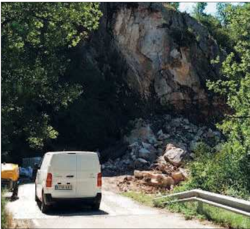
► Obres a la carretera de Torà de Tost.
