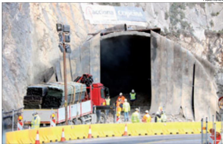
El túnel després de la primera voladura feta en fase de proves.
