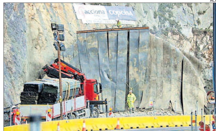
El túnel ahir amb la malla que es posa durant les voladures
