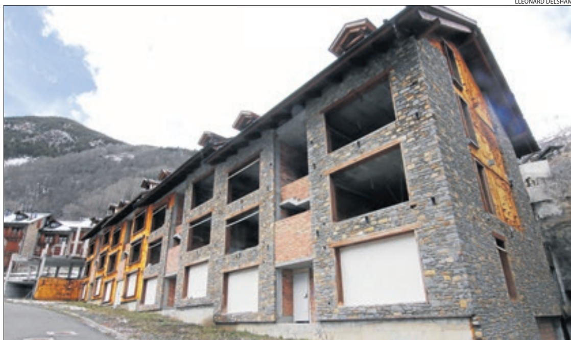
Imatge d'arxiu d'un edifici inacabat a Espui, on la normativa permet un miler de cases.
