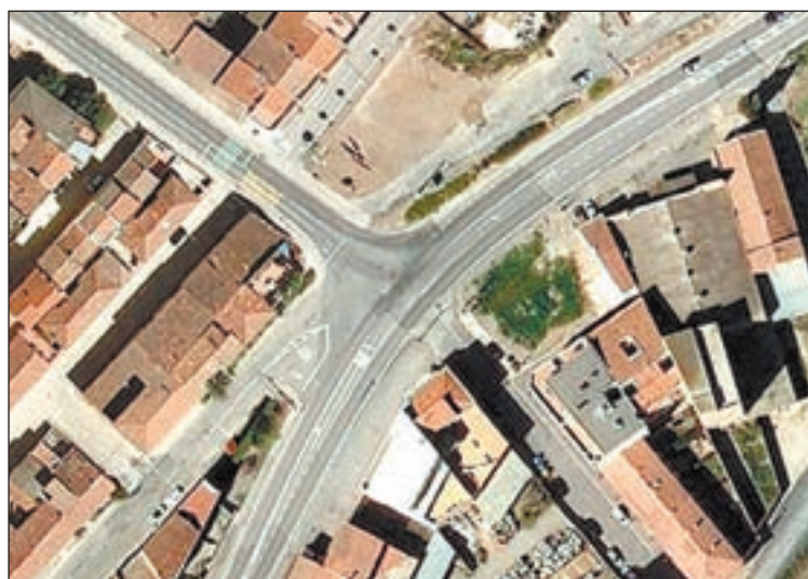
FOTO: ACN / Imatge aèria del punt d'Alcarràs on es construirà la rotonda
