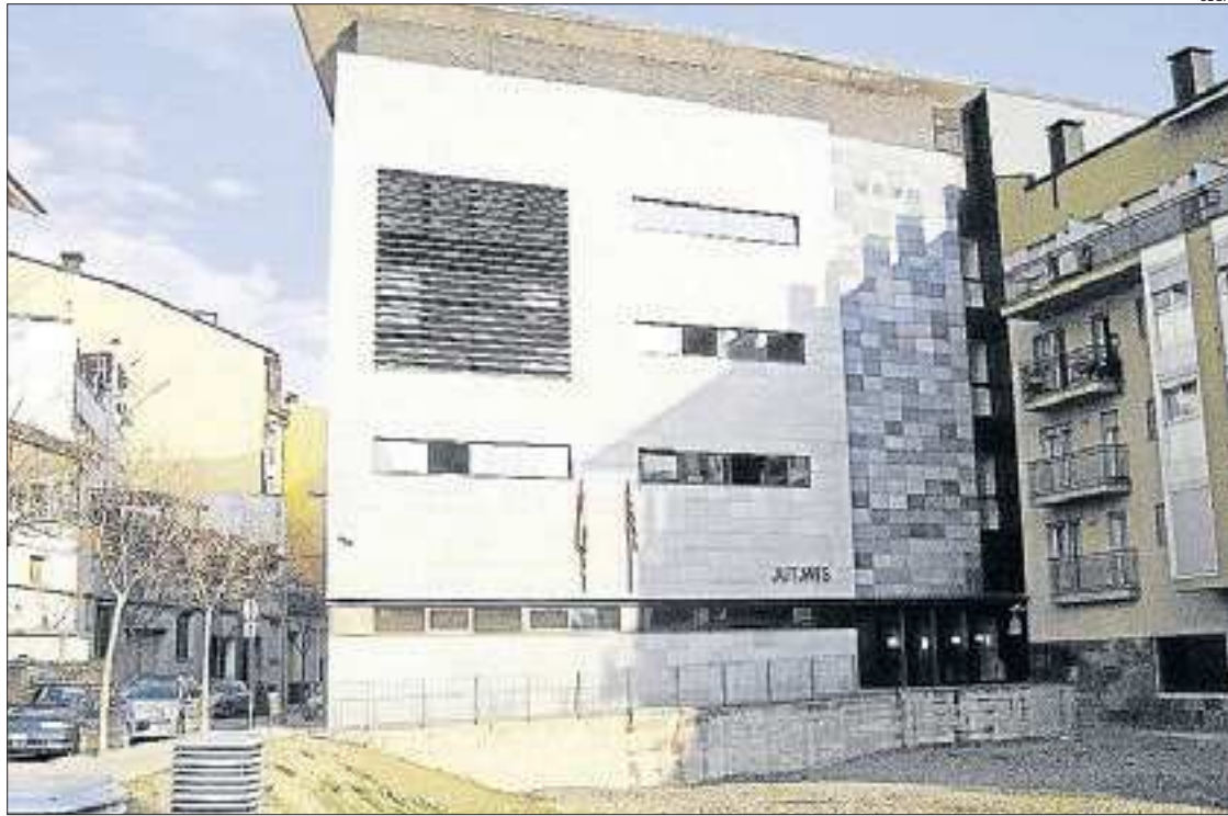
Imatge d'arxiu de l'edifici dels jutjats de la Seu d'Urgell.
