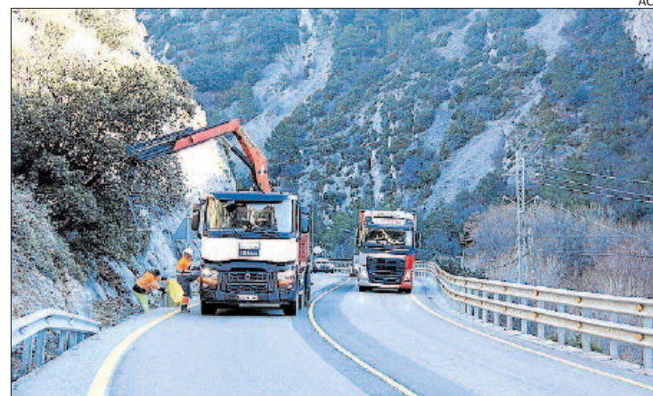
Les primeres actuacions a la carretera C-14 per l'obertura del túnel
