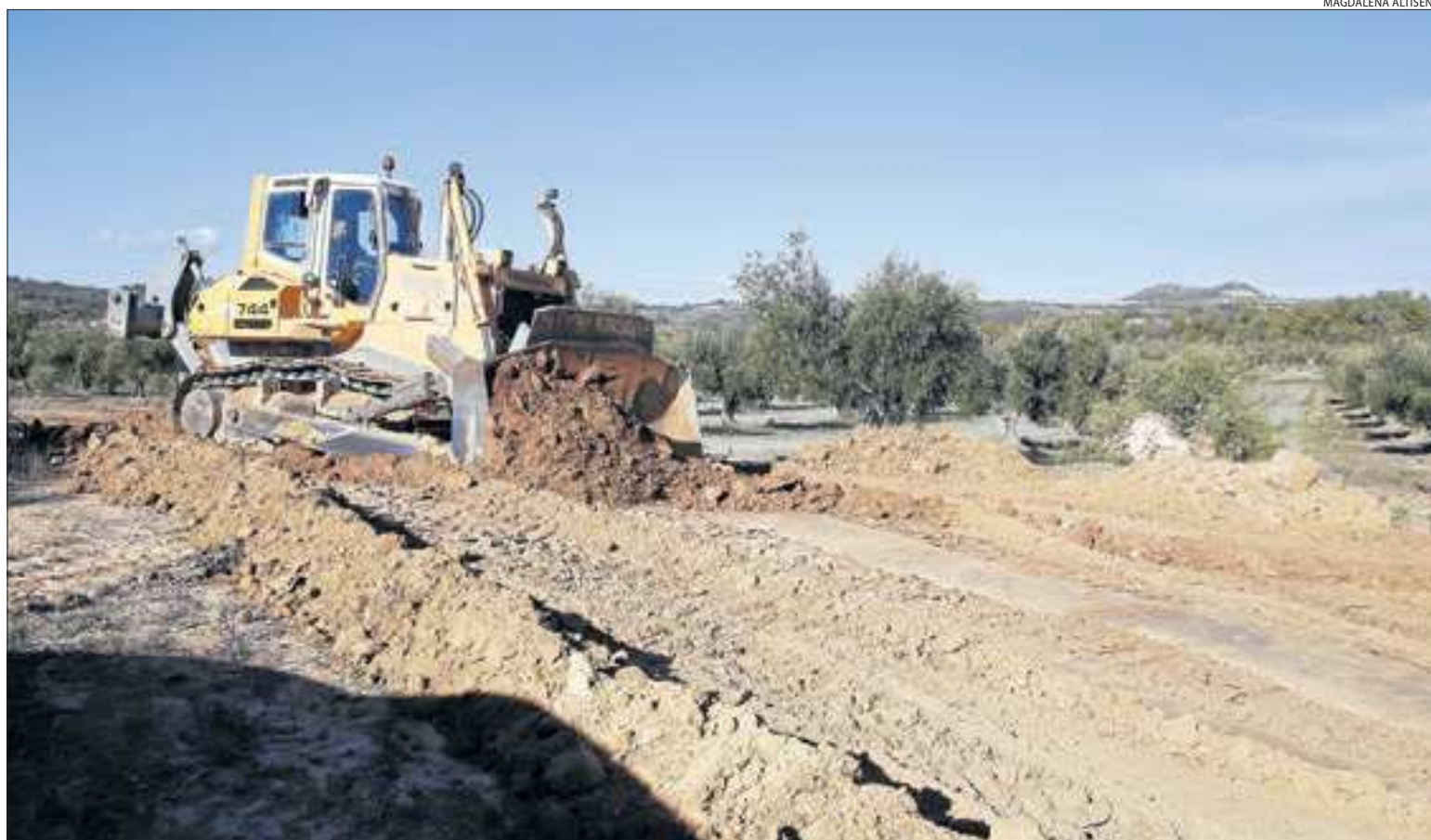
Obres de desbrossament a Cervià de les Garrigues per a la instal·lació de canonades de les xarxes secundària i terciària del canal.
