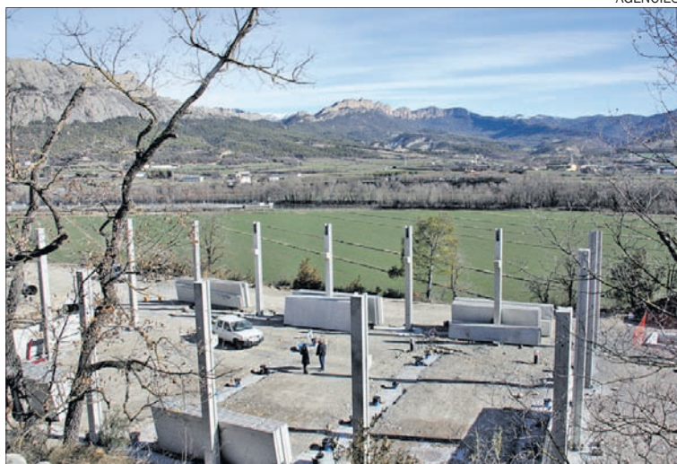
Pla general de l'estació de bombament que s'està construint.
