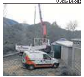
Obres per reparar la bomba.
