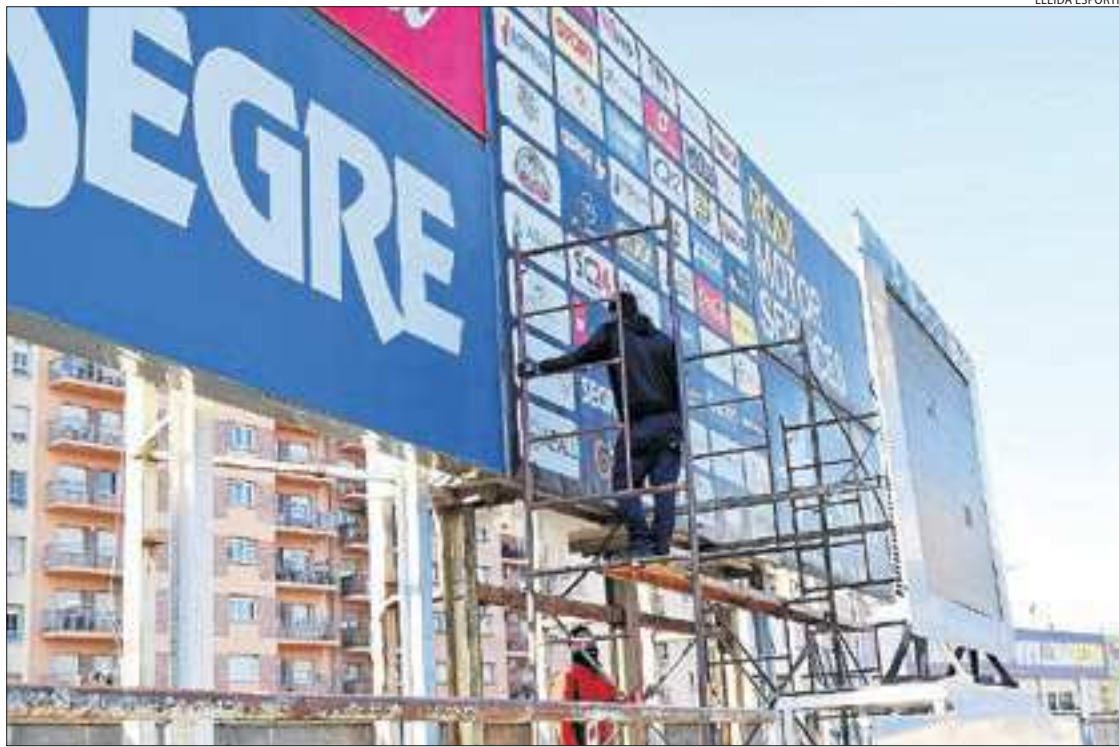
Les obres per a la col·locació del nou i definitiu marcador van començar ahir al Camp d'Esports.
