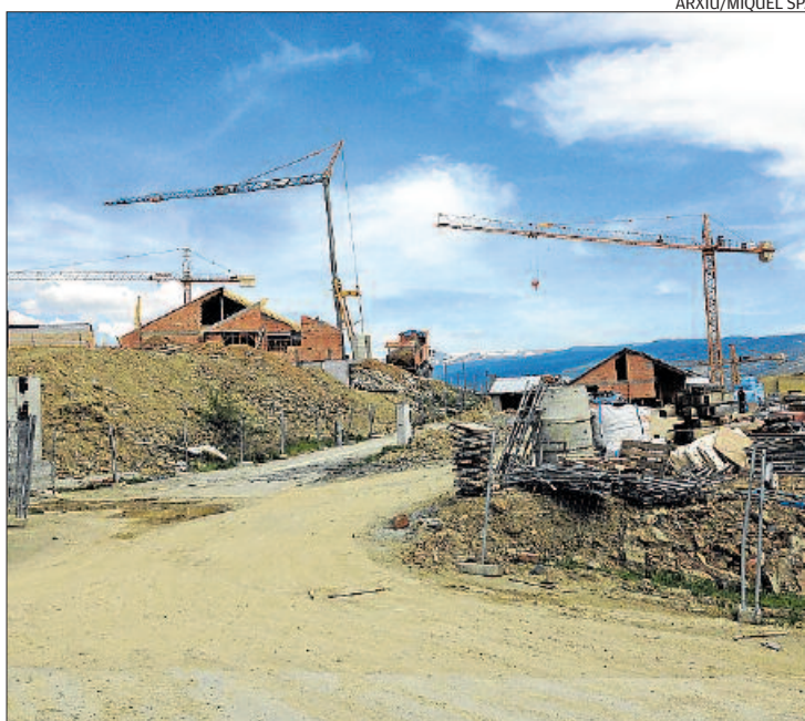
Un terreny en plena construcció de cases al terme municipal de Bolvir
