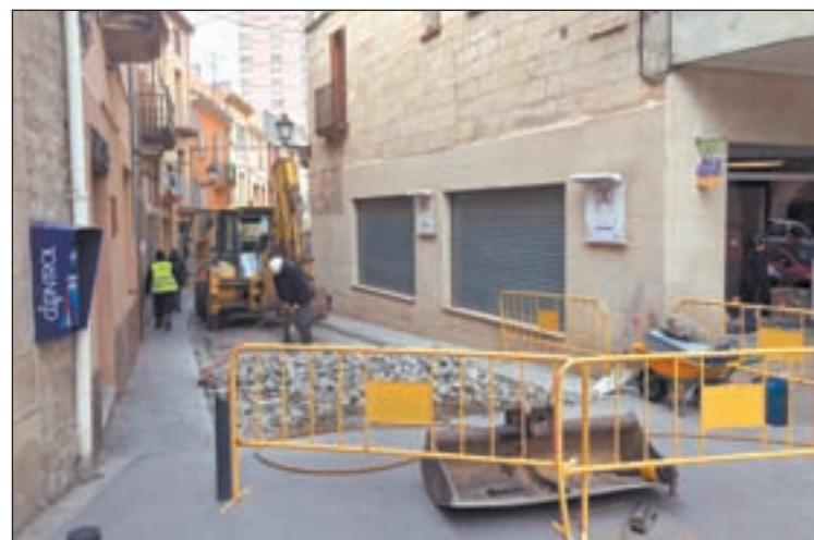
FOTO: Aj. les Borges / Les obres del carrer Concepció Soler iniciades ahir
