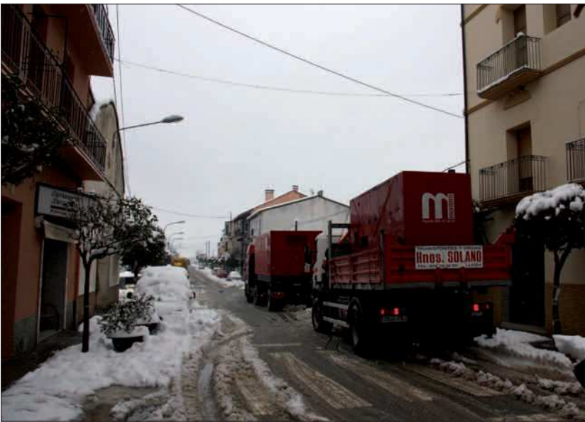
► Generadors d'electricitat a Coll de Nargó, ahir.
