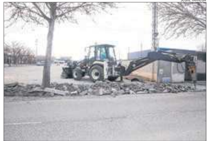
Les obres per al pàrquing d'autocaravanes a Tàrrega.
