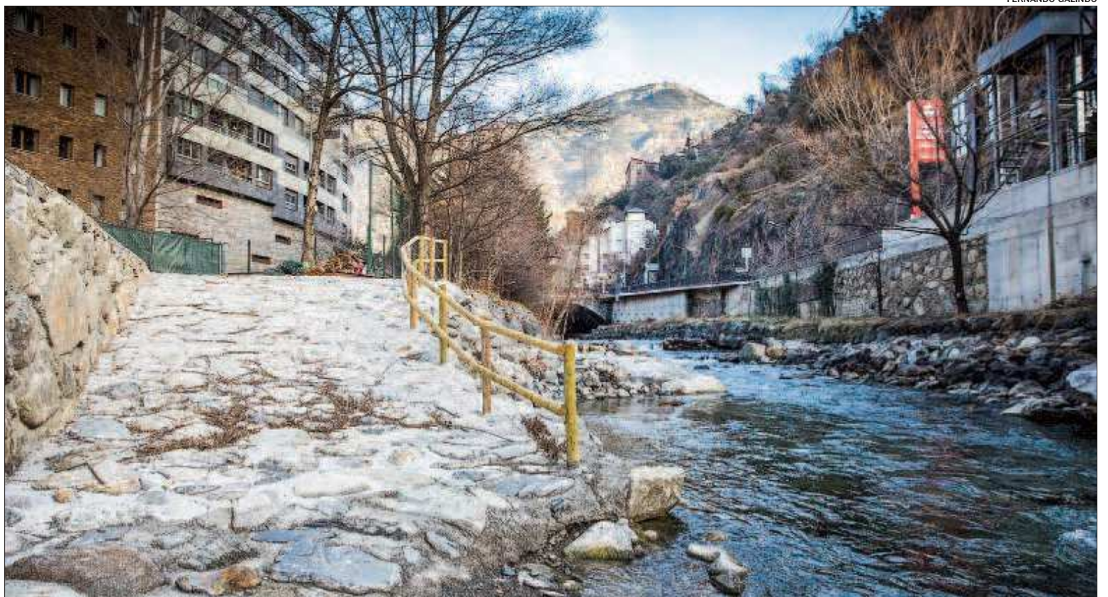
La construcció de rampes per a l'entrada i sortida de les barques s'ha realitzat des del pont i riu avall.
