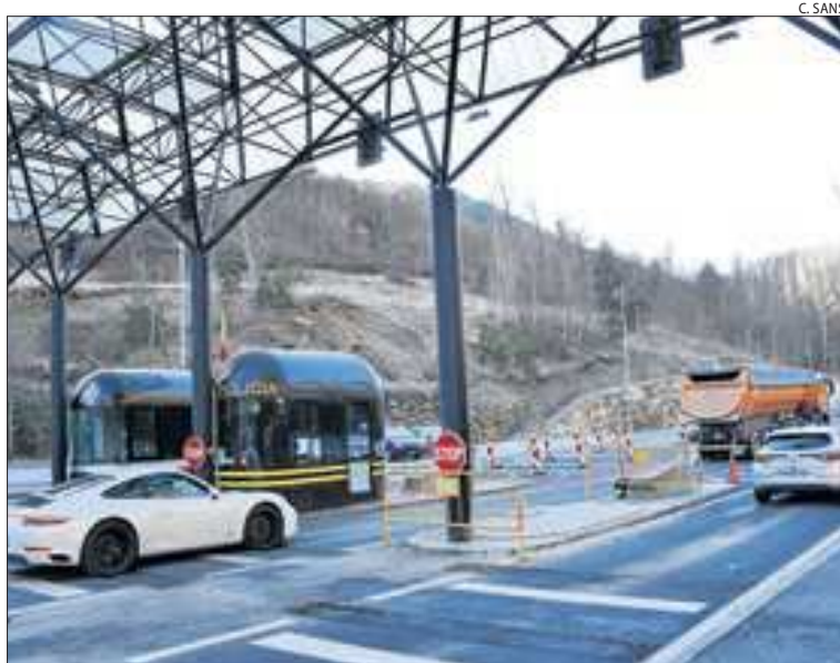
La remodelació inclou renovar les casetes del control.
