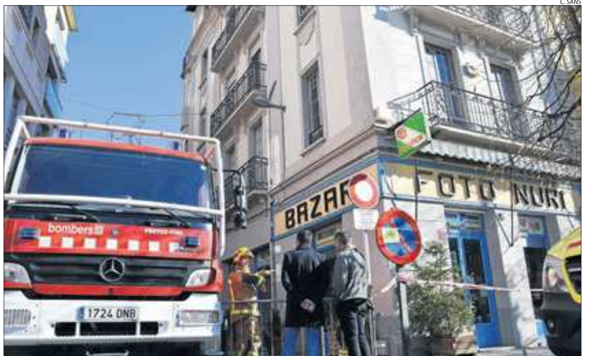
Bombers davant de l'immoble afectat ahir per l'ensorrament, situat al centre de la Seu d'Urgell.
