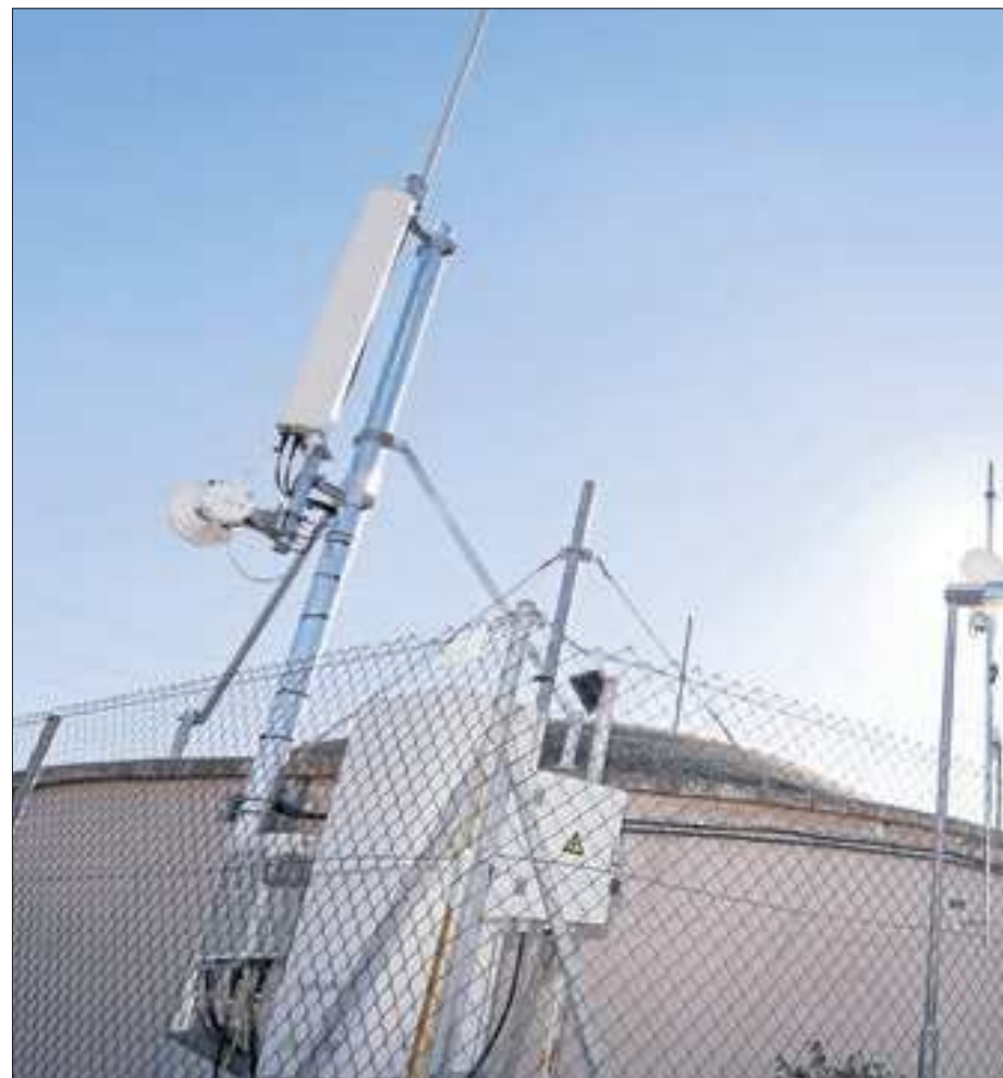
Antenes d'empreses operadores de WiMax instal·lades al dipòsit municipal d'aigua
