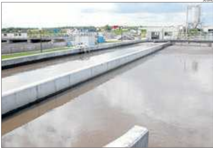
Imatge d'arxiu de la depuradora de Tàrraga.
