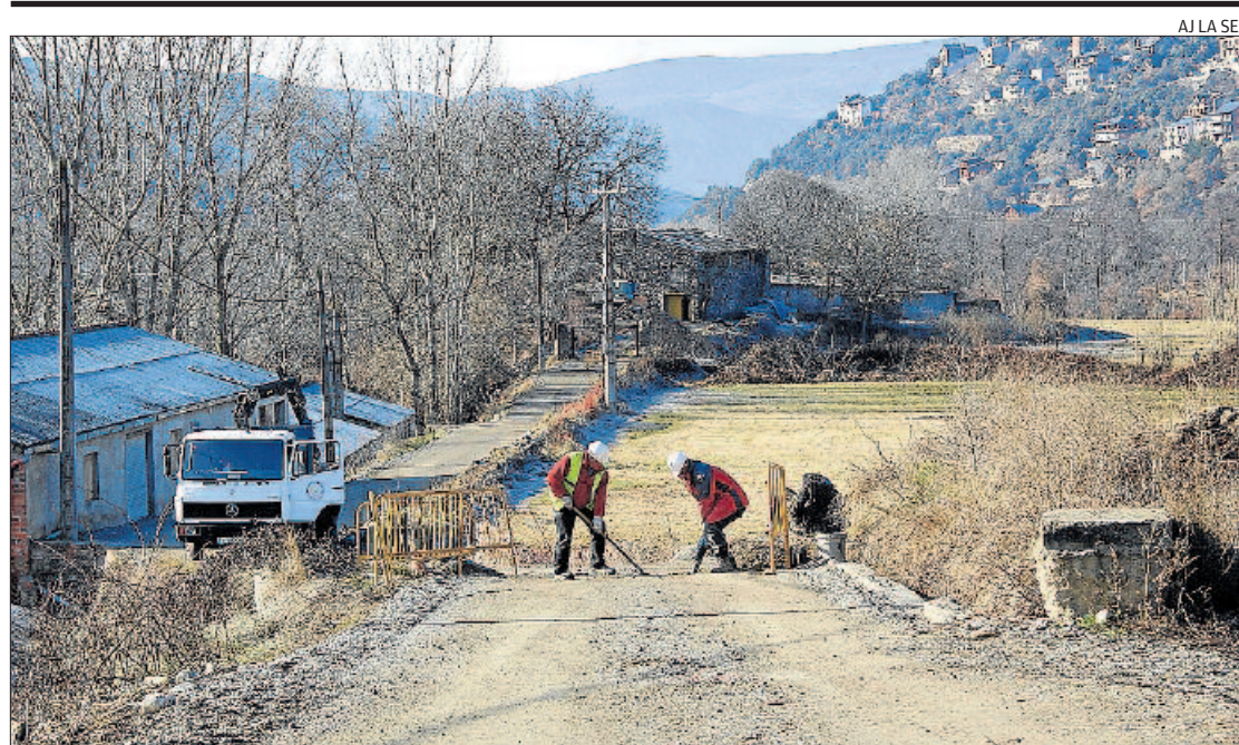
Les obres de millora del camí de Santa Magdalena de la Seu, que dona accés a cases i horts
