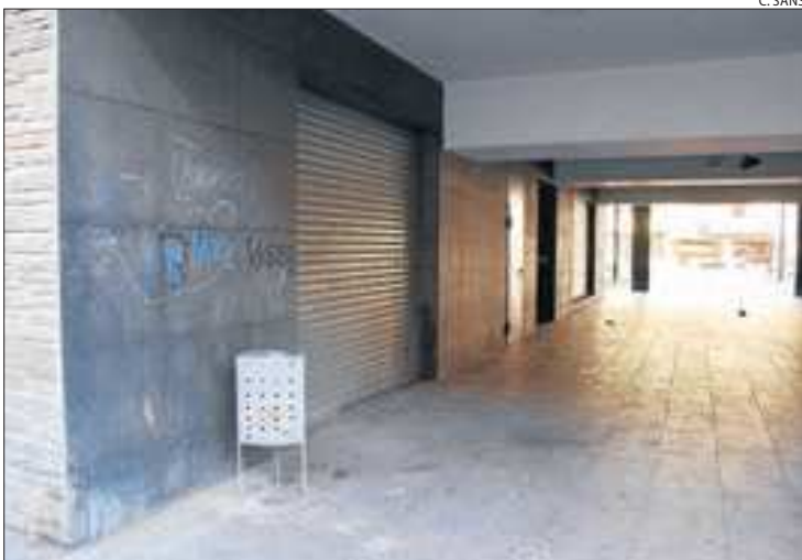
El túnel d'accés dels edificis Codina 5 i 6 de la Seu d'Urgell.
