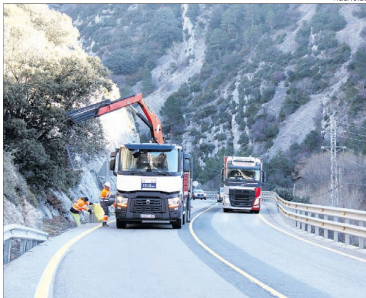
Diversos operaris descarregant les barreres de formigó durant el dia d'ahir.
