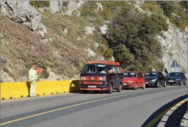
Un operari de l'obra regula el pas alternatiu, ahir. C.SANS
