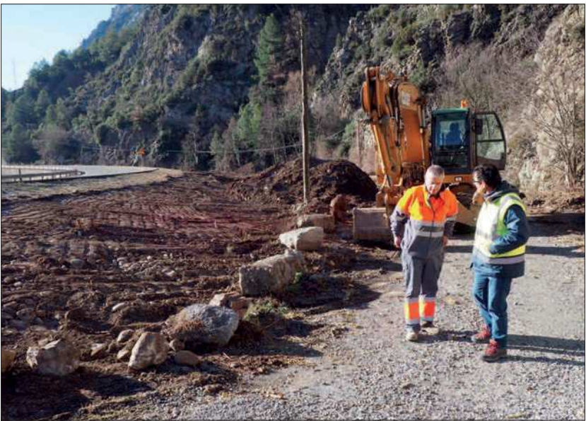
Primers treballs per a la construcció del túnel de Trespunts, ahir.
