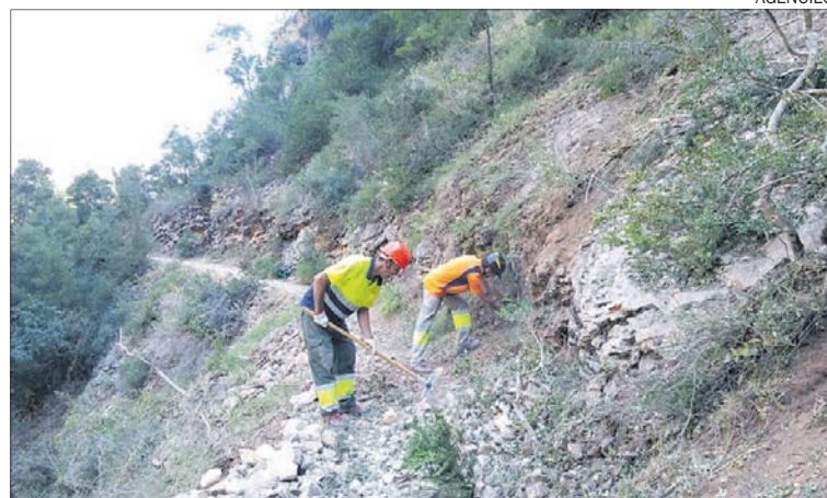
Operaris del Consell Comarcal treballant en la retirada de roques.
