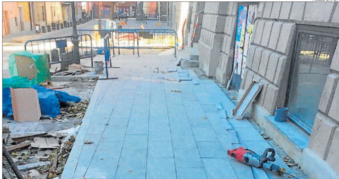
Els treballs d'instal·lació dels panots Stone Puigcerdà a la nova plaça Barcelona de la capital cerdana
