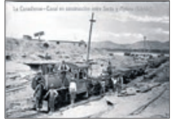
Canal de Seròs en construcció.
