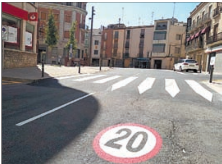
FOTO: La Paeria / Imatge del pas elevat que s'ha construït en el tram
