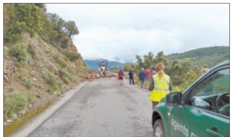
FOTO: / L'accés a Castellbò es va veure afectat per un desprendiment
