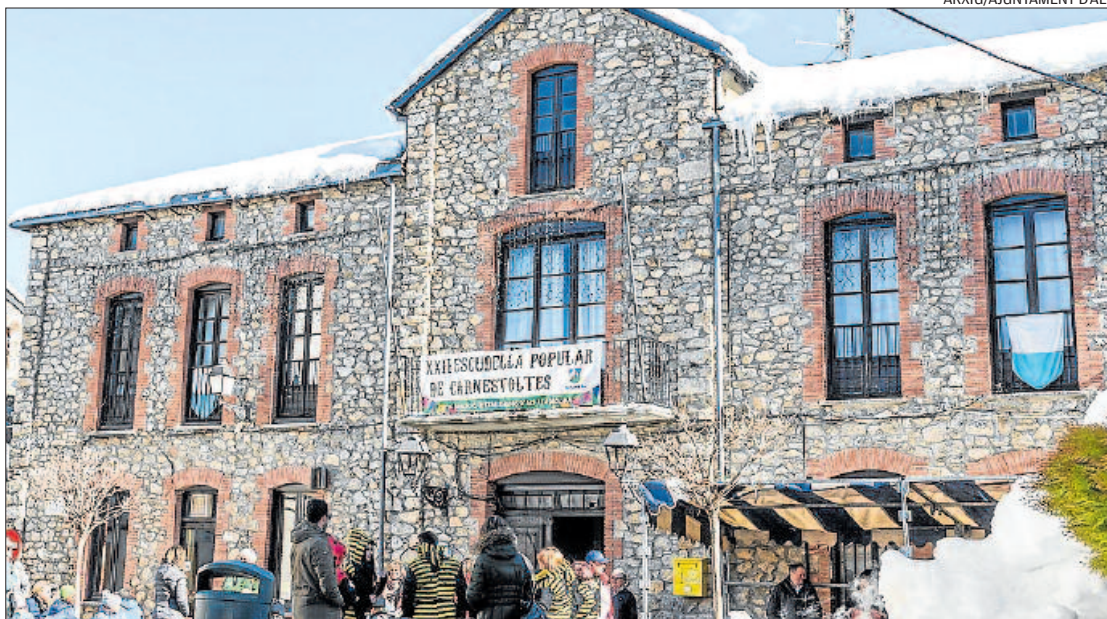
L'edifici del teatre i del casino d'Alp, al centre del poble, que l'Ajuntament vol rehabilitar i ampliar
