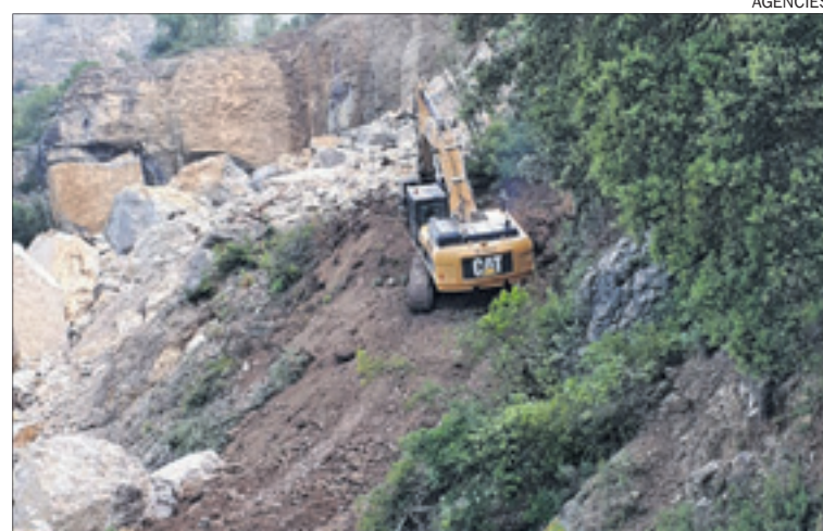
Una màquina retroexcavadora retirant runa, ahir.
