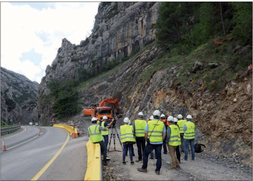
►► Inici de la perforació del túnel de Trespunts.
