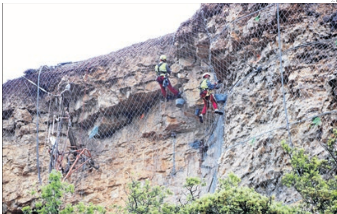
Operaris col·loquen malles contra desprendiments ancorades fins a 15 metres de profunditat.
