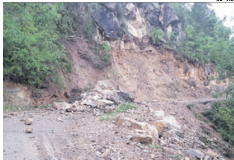
L'Ajuntament avaluarà el risc de desprendiments que hi ha a la zona.
