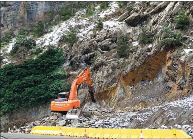
► Obres a la C-14, al congost de Trespunts.
