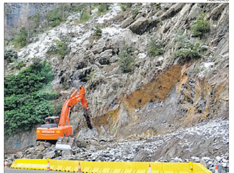
Màquina treballant a la boca nord del futur túnel de Trespunts.
