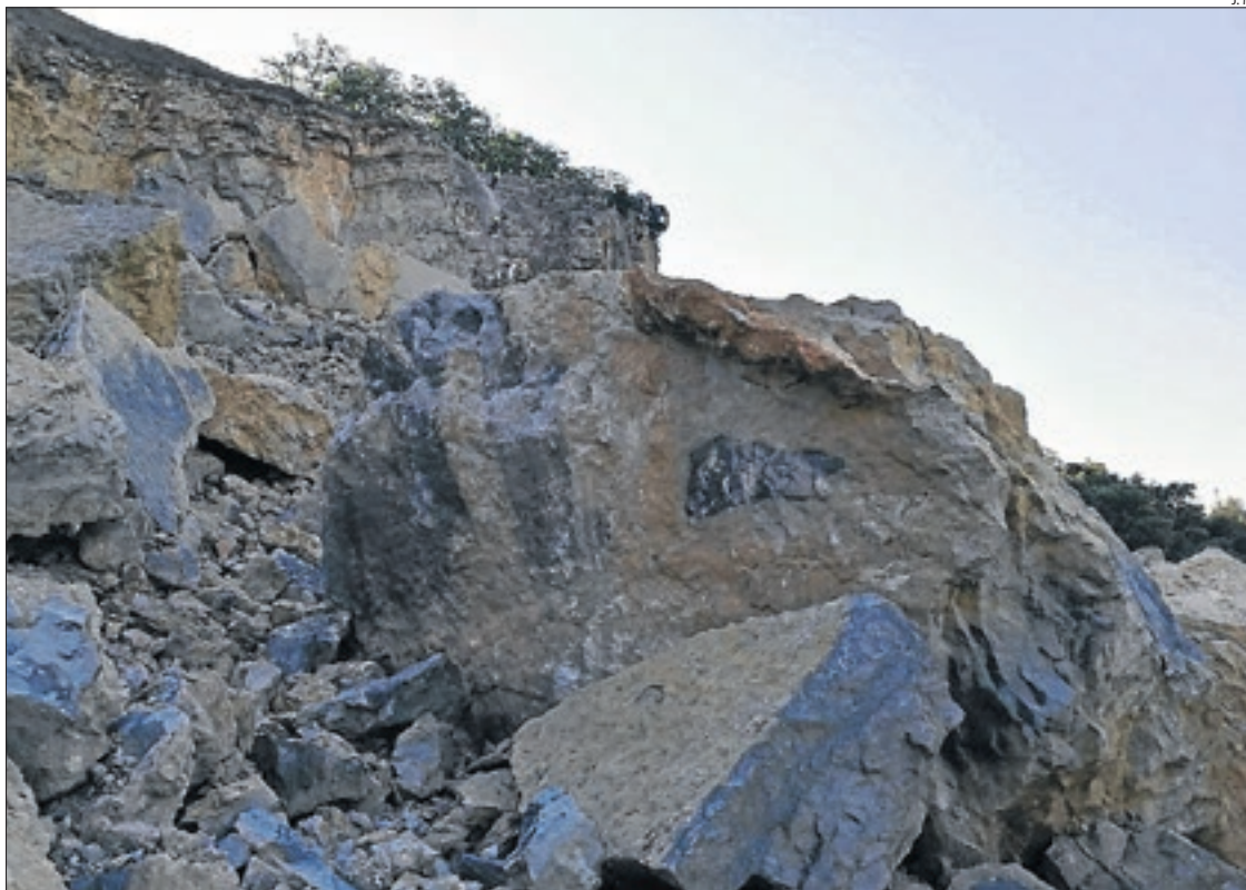
Personal contractat centra els treballs encara en l'estabilització del pendent.
