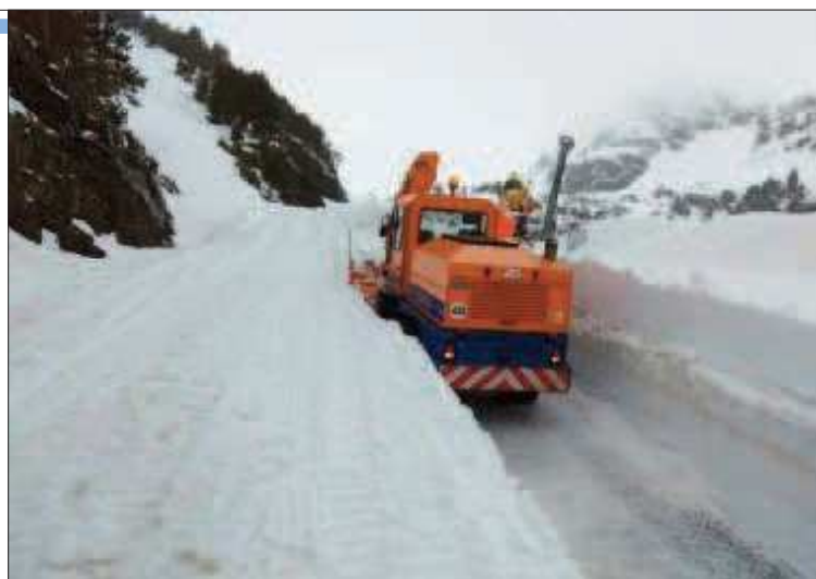
Una màquina del COEX treballant a la carretera de la Coma, ahir.
