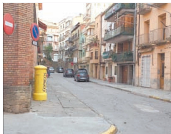
FOTO: J. Arimany / L'estat del carrer Bisbe Bernaus abans de les obres
