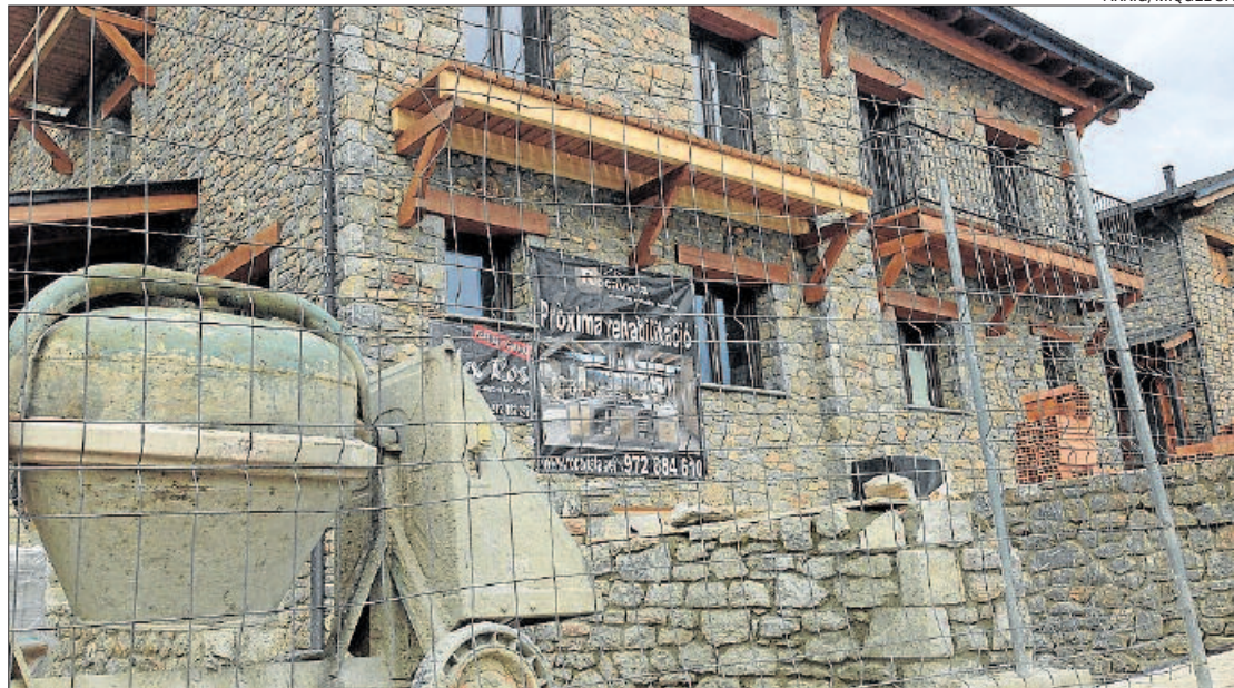
Les obres de construcció de cases unifamiliars a Bellver de Cerdanya mostren la recuperació del sector
