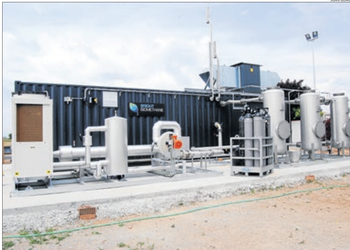
La planta depuradora del gas metà a Vila-sana, pràcticament acabada.
