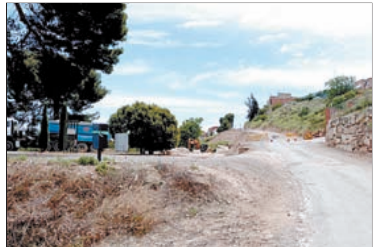
FOTO: Aj.Borges / Imatge de les obres que s'estan realitzant
