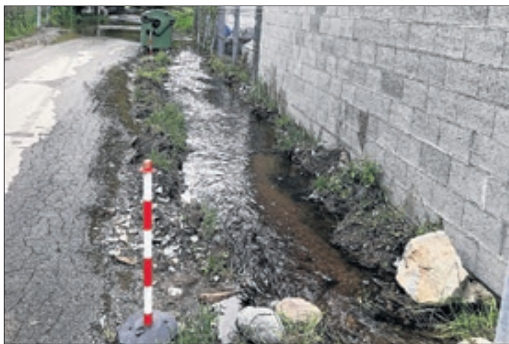
L'aigua del barranc de Son a les portes de la deixalleria d'Esterrí.
