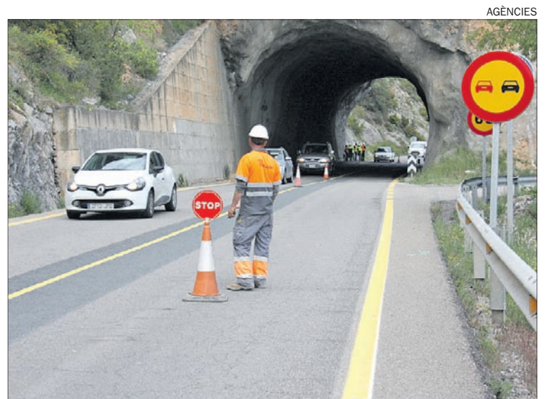
L'actual túnel de Trespunts, un cop acabades les voladures de prova d'ahir.
