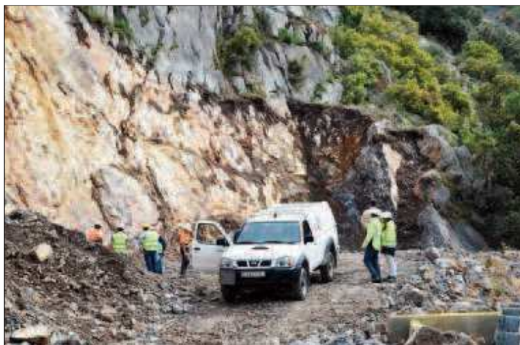
Imatge de les proves de perforació del túnel, ahir.
