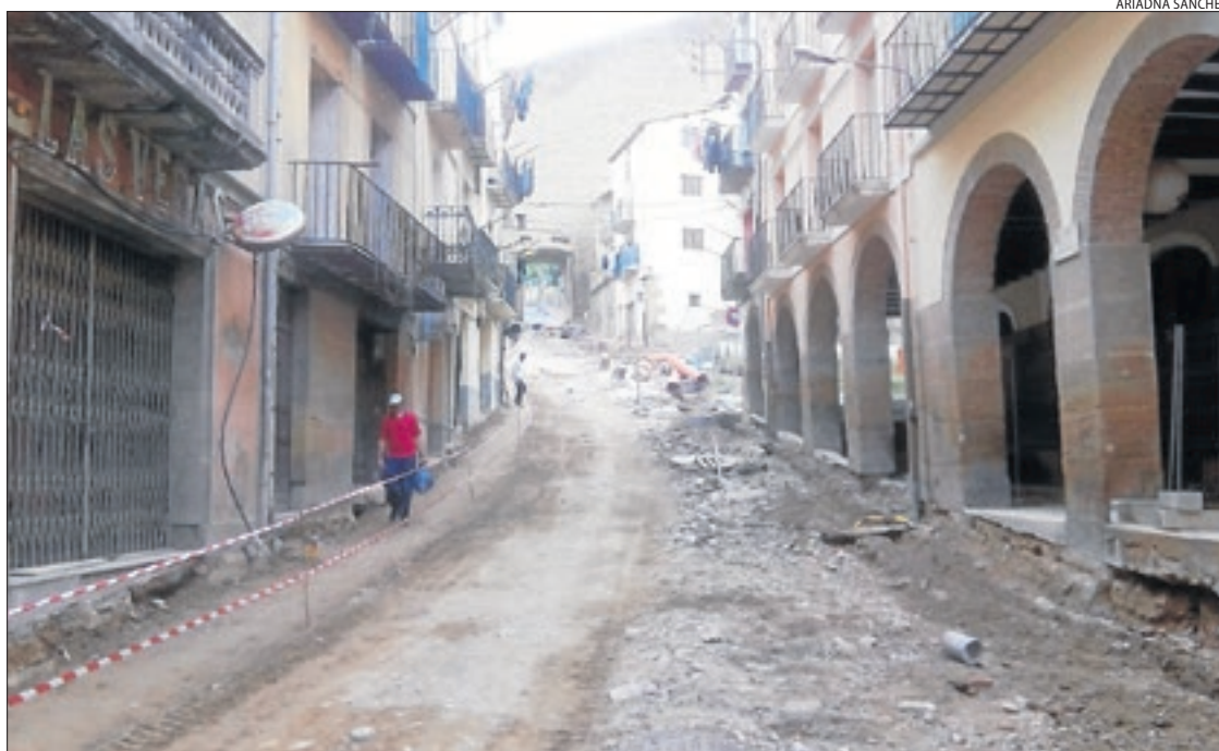
Les màquines ja havien compactat ahir part del carrer Botera del centre històric.
