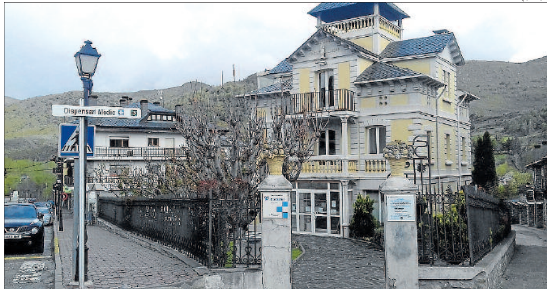
L'històric edifici noucentista de la Torre Sant Josep de Bellver, que serà rehabilitat per millorar el CAP
