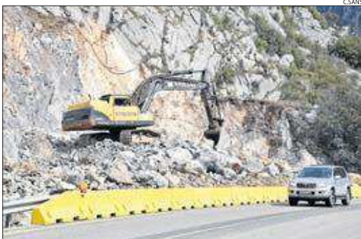
Operaris treballant a la boca nord del túnel de Tres Ponts.
