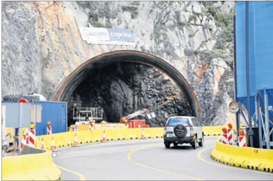
Els operaris treballaven ahir a la boca sud del túnel de Tres Ponts.
