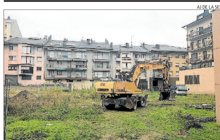
Les màquines al solar on es començarà a construir l'edifici de serveis
