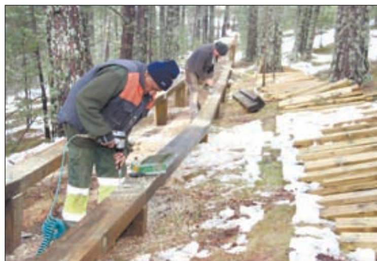
FOTO: Albert Lijarcio / Dos operaris millorant els accessos a l'estació
