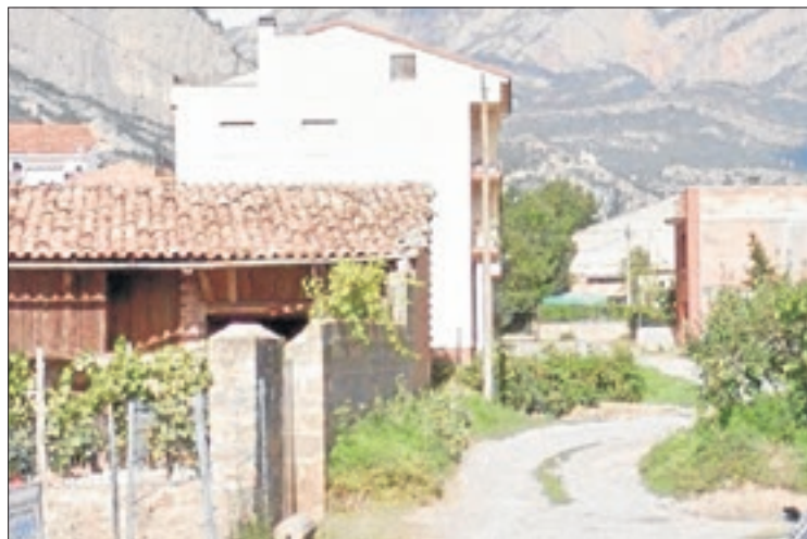
El carrer Enric Granados d'Oliana, que ara s'asfaltarà.
