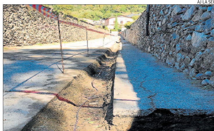
Les obres del carrer Bellavista de la Seu d'Urgell iniciades recentment
