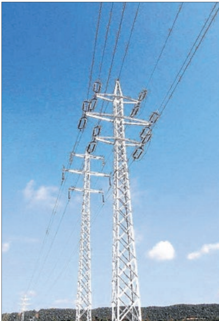
Imatge d'arxiu d'una torre elèctrica.
