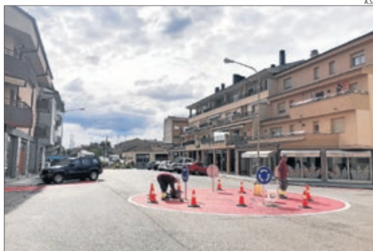
La rotonda que s'ha habilitat al carrer de Solsona.
