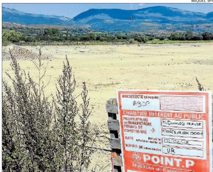
Els terrenys que s'estan preparant per a la superfície comercial i d'oci
