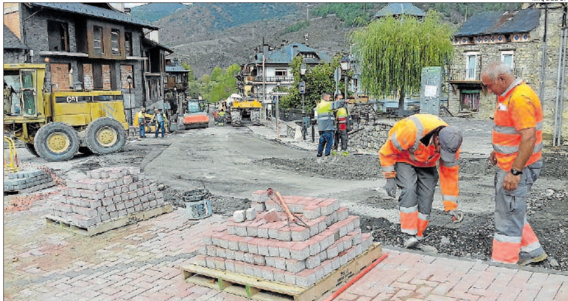
Les obres de pavimentació del vial i de col·locació de llambordes a la plataforma per a terrasses i vianants
